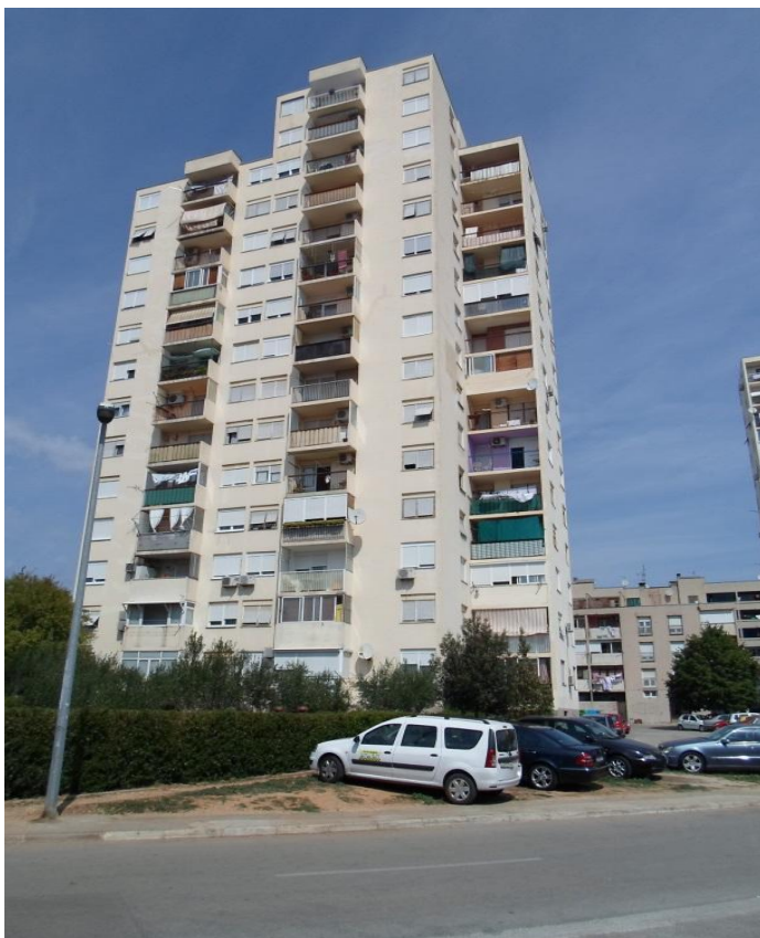
Slika 1. Južno pročelje zgrade
