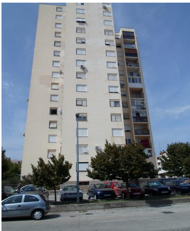
Slika 3. Istočno pročelje zgrade
