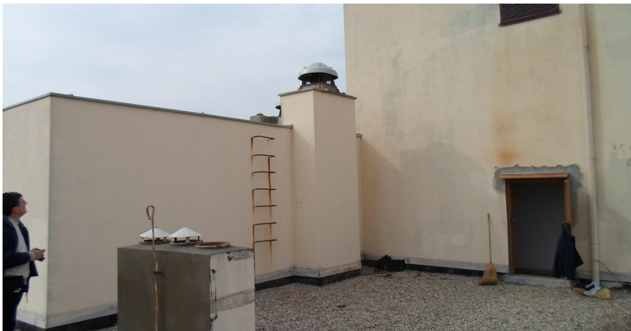
Slika 9. Dio ravnog krova s otvorima
